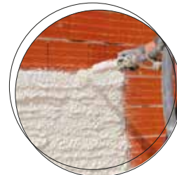
Argamassa Térmica condutibilidade: 0,050
