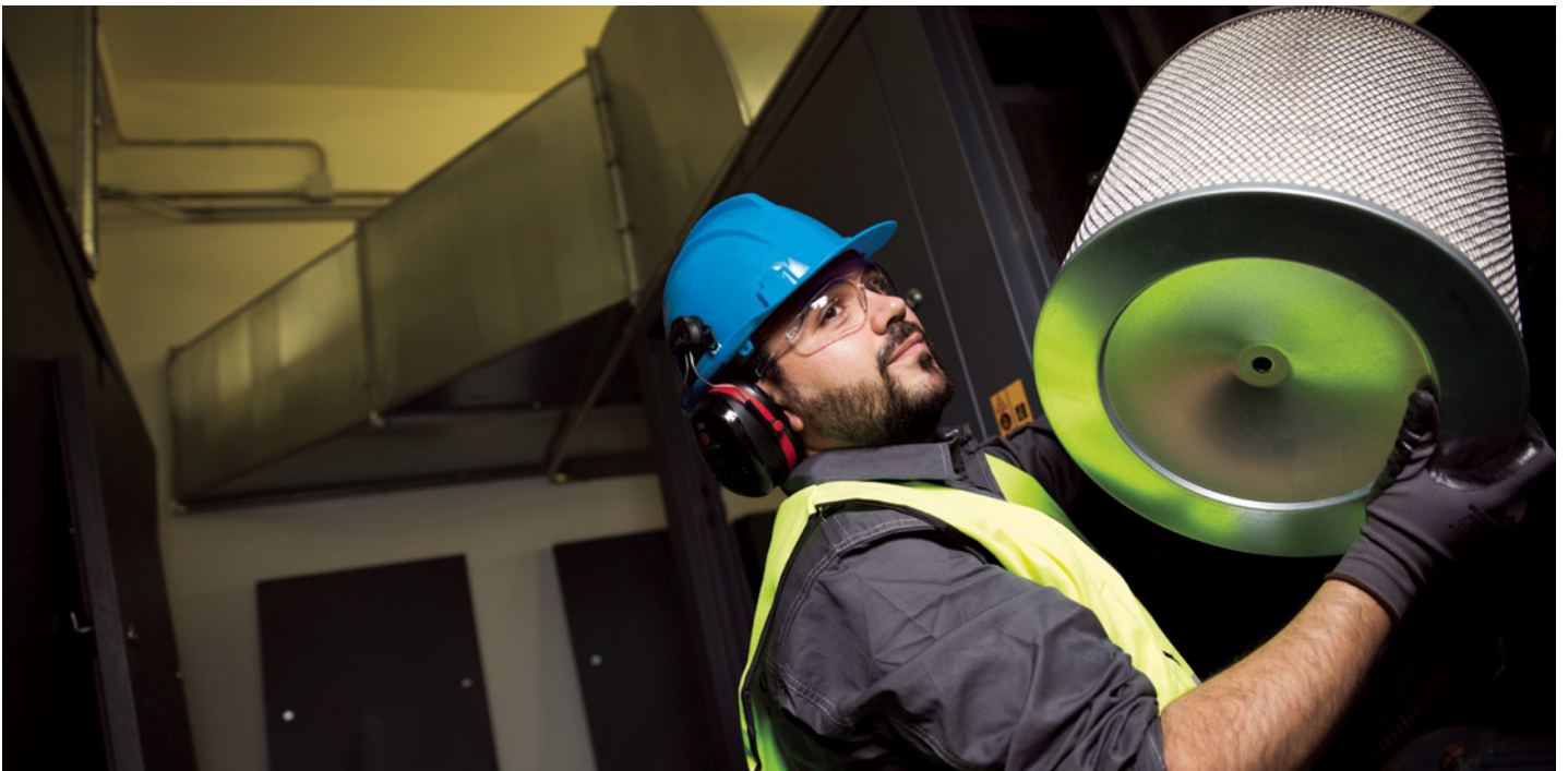
Fig.4- Ação de manutenção de compressor
